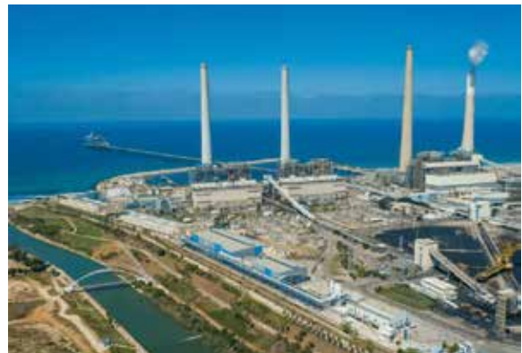
Entsalzungsanlage Hadera, Foto: IDE Technologies
